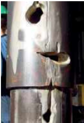
Рис. 2. Отверстия в колонне НКТ после обильных пескопроявлений
