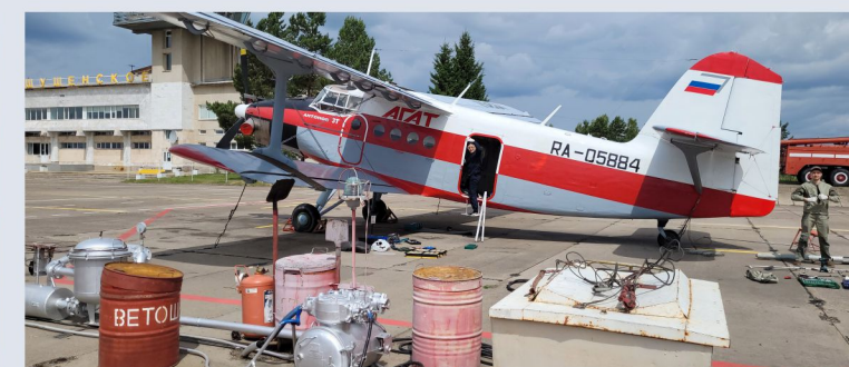
Монтаж а аэропорту Шушенское
