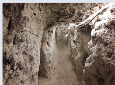
Современные штольни в выветрелых гранитных пегматитах
