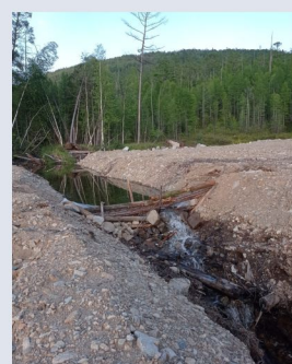
Гидротехническое сооружение Алданской партии
