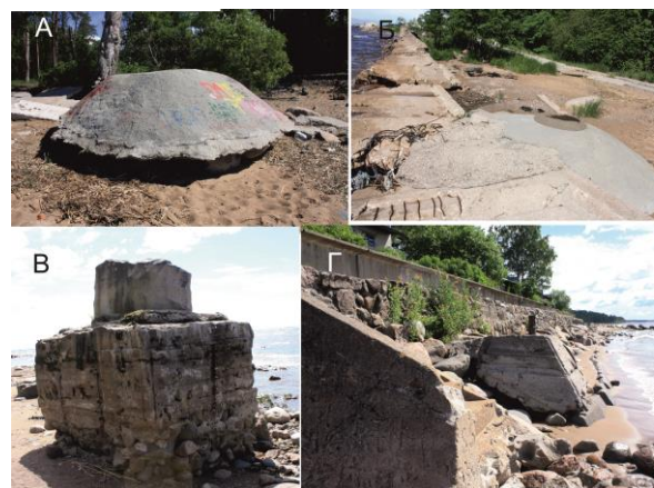
Рисунок 90. Шахты системы канализации вблизи уреза воды. А – станция наблюдения 14-КурБ-5; Б – станция наблюдения 14-КурБ-6
