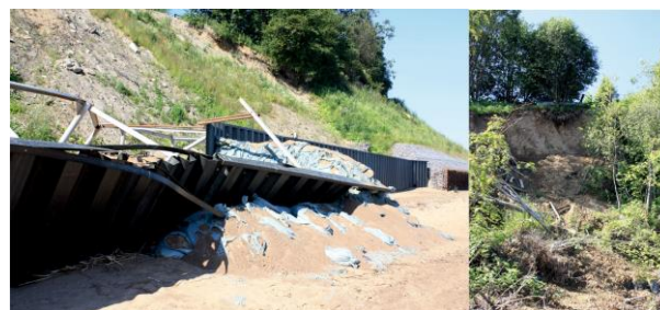
Рисунок 106. Активные абразионно-обвальные процессы к востоку от берегозащитного сооружения в пос. Красная Горка. Станция наблюдения 14-Л-6
