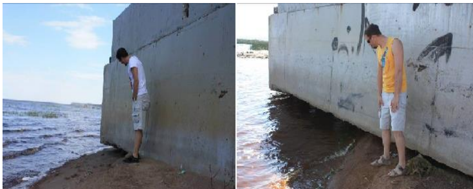
Рисунок 107. Размыв основания пирса МЧС, пос. Лебяжье
