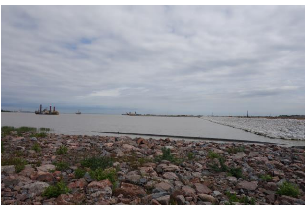
Рисунок 83. Строящийся порт «Бронка» в акватории Невской губы. Вид с КЗС. 2 июня 2015 г., район т. н. 15-НГБ-ЛОБ-01 (15-НГБ-66)
