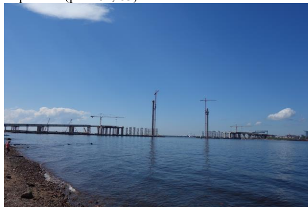
Рисунок 80. Строительство автодороги от Крестовского острова на Васильевский через Малую Невку и Малую Неву. Снимок сделан с северного берега В. О. 23 июня 2015 г., район т.н. 15-НГБ-В01 (15-НГБ-29). Фото Н.Б. Малышевой
