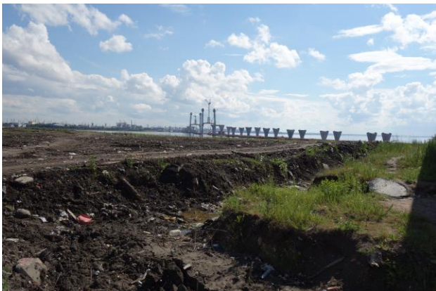
Рисунок 81. Опоры, установленные в акватории Невской губы под ЗСД от Васильевского острова к Канонерскому острову. Снимок сделан со Шкиперской свалки В. О. 23 июня 2015 г., район т. н. 15-НГБ-В02 (15-НГБ-30). Фото Н.Б. Малышевой
