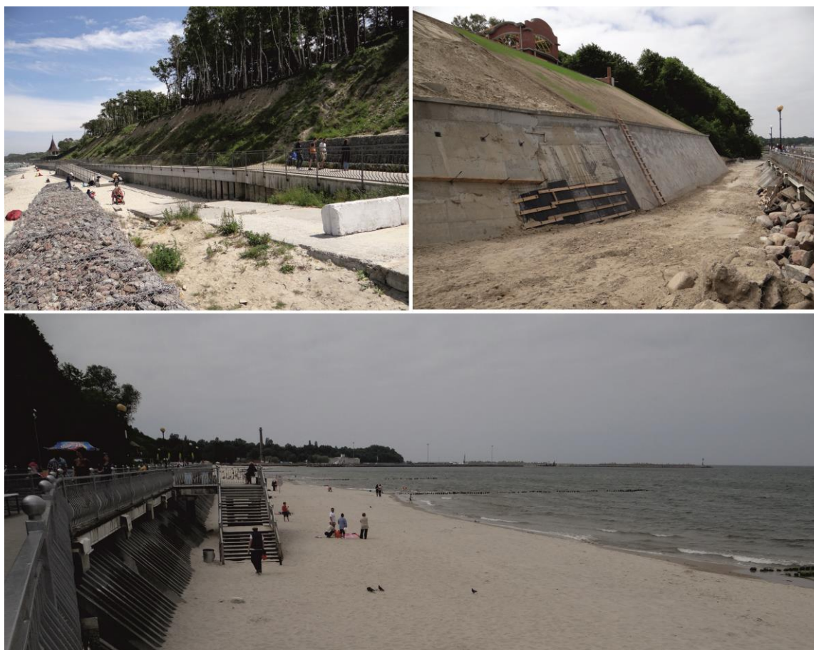
Рисунок 109. Состояние берегоукрепительных сооружений в районе г. Пионерский
