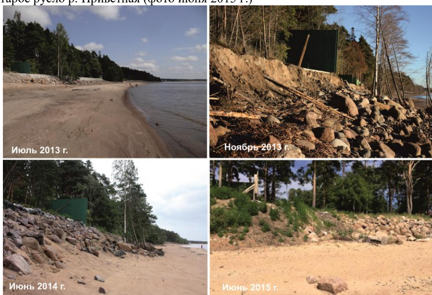
Рисунок 33. Развитие абразионных процессов и разрушение берегозащитных сооружений в районе пос. Солнечное
