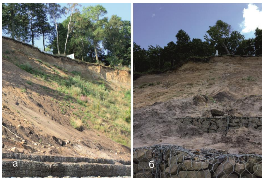
Рисунок 112. Развитие склоновых процессов: а – 2014 г., забор на вершине клифа и дерево стабильны, б – 2015 г., дерево наклонено, забор нависает над склоном
