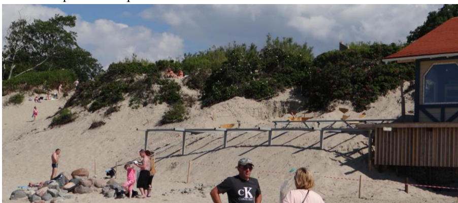
Рисунок 538. Строительство сооружений на склоне авандюны с частичным ее разрушением
