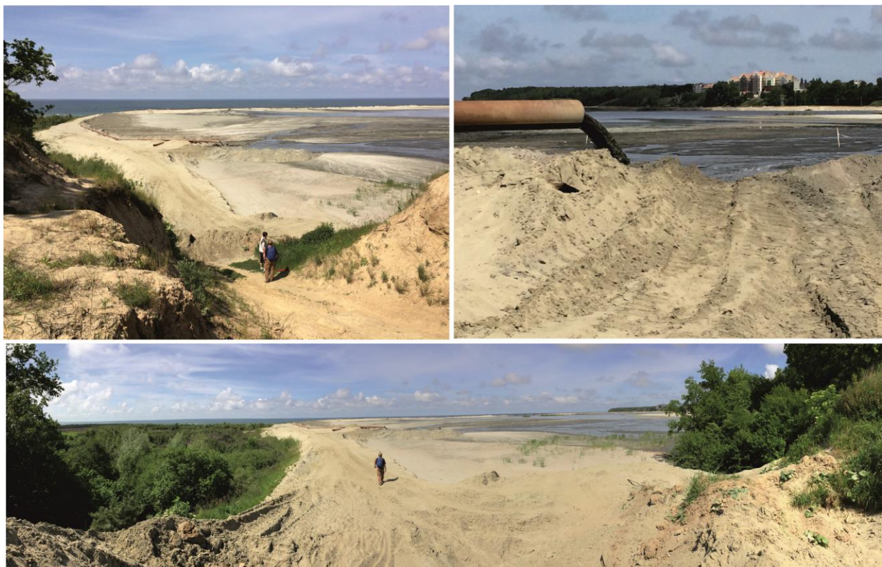
Рисунок 123. Отвалы пульпы Янтарного комбината, расположенные на техногенном побережье в районе пос. Покровское
