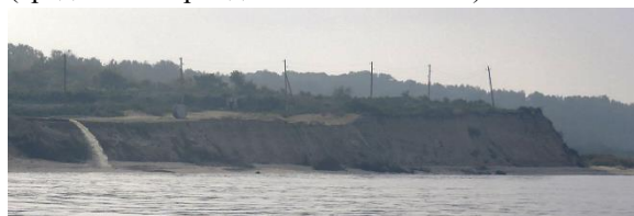
Рис. 121. Дамба, отделяющая карьер на севере пос. Синявино от моря. Из трубы производится слив воды из карьера
