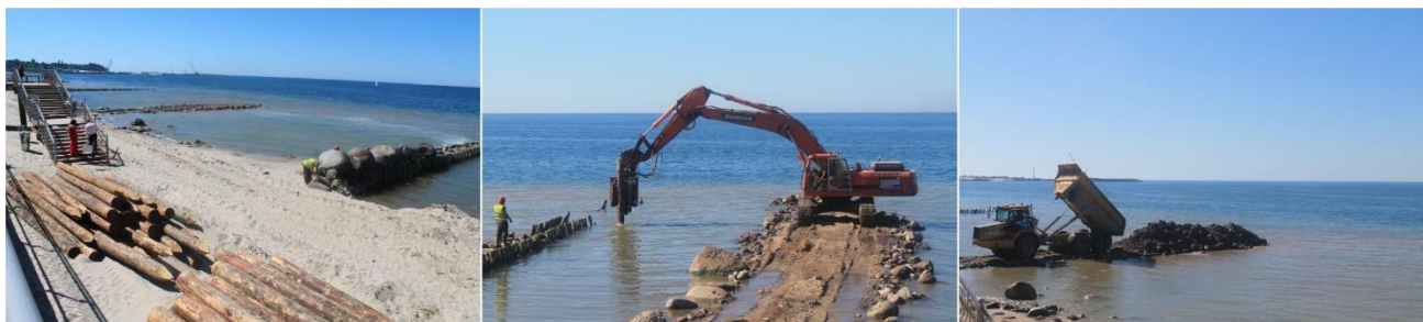
Рисунок 73. Ремонтно-восстановительные работы в восточной части Пионерской бухты в 2018 г.
