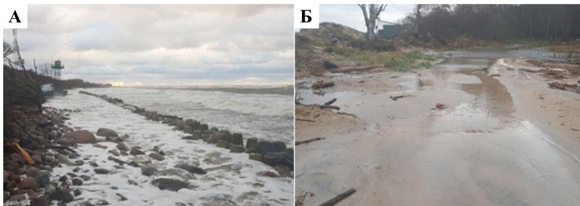
Рисунок 110. Шторм осени 2018 г., т.н. 18-ККБ-12: А – полный размыв пляжа за тетраподами у здания КПП; Б – затопленная низина за авантюной; фото 25 октября 2018 г. ( park-kosa.ru/en_novosti/publikatsii )
