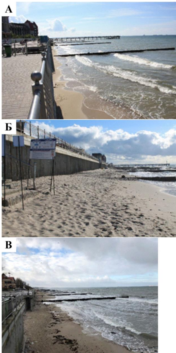
Рисунок 112. Новая система берегозащиты в районе променада г. Зеленоградск, т. н. 18-ККБ-15 – 18-ККБ-16: А – 2017 г., Б – 2018 г., В – фото 14.11.2018 г. (фото А. Крека)
