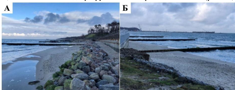
Рисунок 76. Восстановление пляжа после шторма (А) и оползневые процессы на склонах (Б) в Пионерской бухте после шторма 23-24 октября 2018 года (фото А.В. Крека, 14 ноября 2018 г.)
