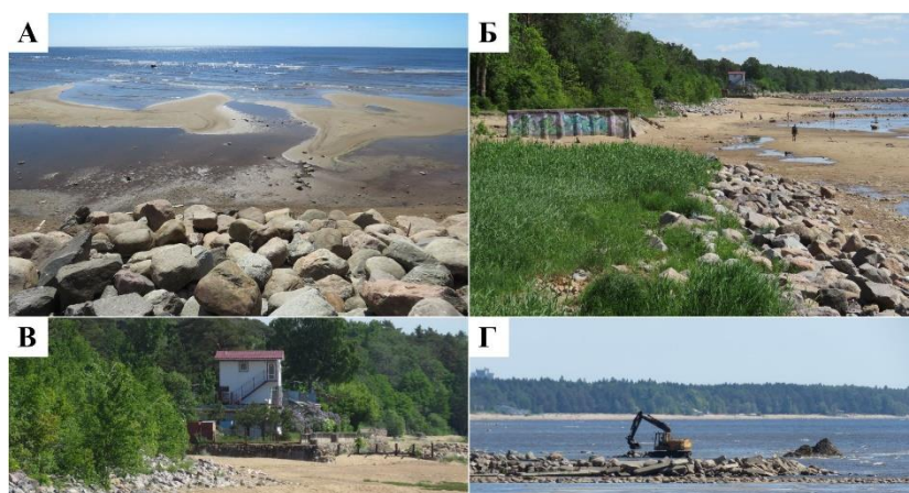
Рисунок 28. Процессы заносимости, т.н. 18-ПК-7. А – аккумулятивные песчаные формы на подводном береговом склоне, сформировавшиеся при размыве отвалов грунта из фарватера Зеленогорского яхт-клуба; Б, В – формирование пляжа на абразионном участке берега перед берегозащитными конструкциями; Г – дноуглубление фарватера лодочного кооператива
