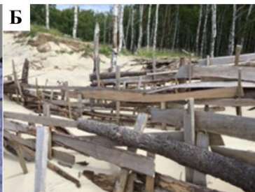
Рисунок 120. Котловина выдувания ККК-6: А – трехмерная модель; Б – фото склона с пескоудерживающим сооружением
